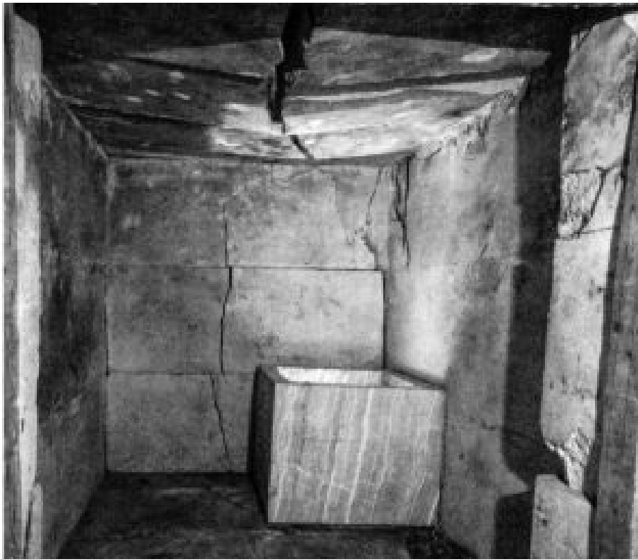
Fig.30.3. Las losas rotas del techo de la capilla ka S 15 de la pirámide de Amenemhat III en Dashur.
